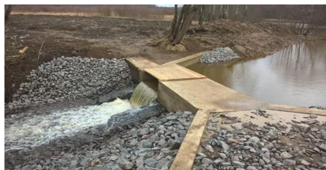
Рис. 3. Существующие инженерные водопропускные сооружения, требующие модернизации в территориальных границах Краснодарского края
