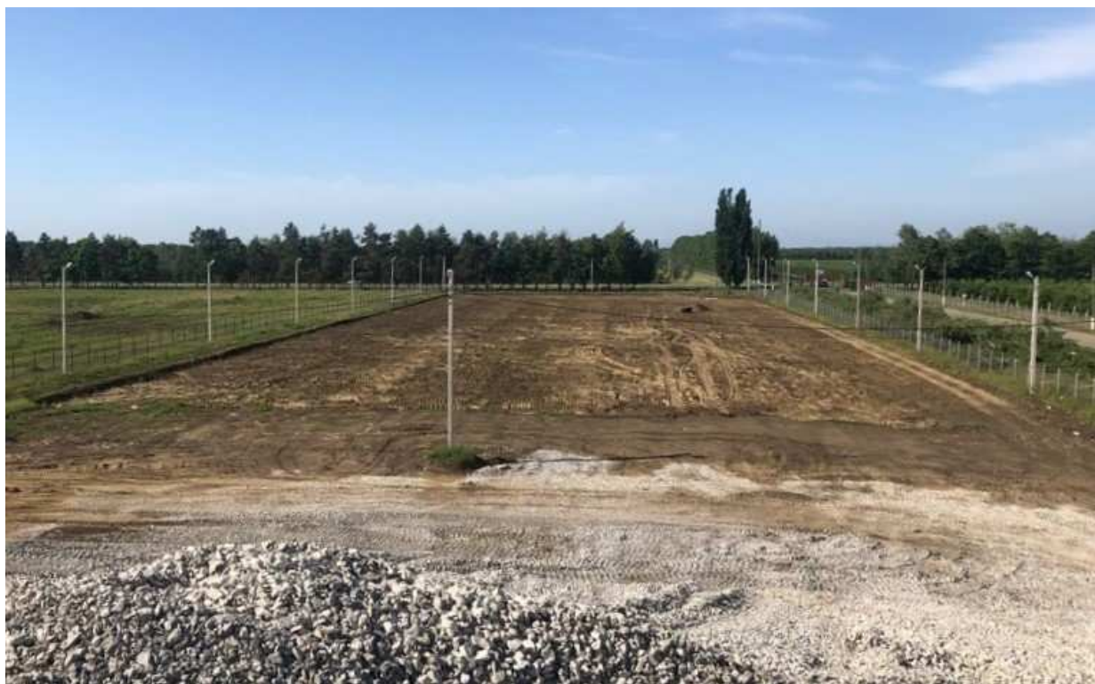
Рисунок 1 –Производство работ по устройству дорожной одежды парковки грузового и легкового автотранспорта
