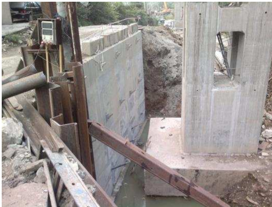
Рисунок 6 – Устройство анкерных свай и облицовочной панели в защитном сооружении опоры №28 (эстакада №3)
