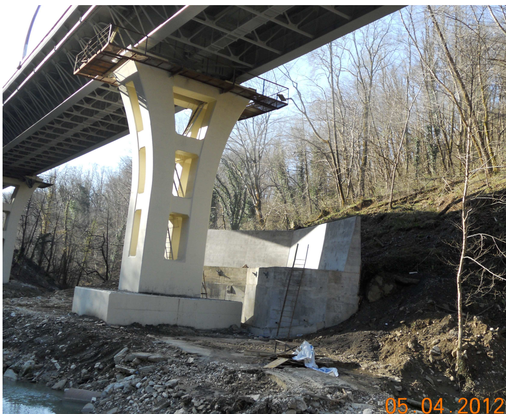
Рисунок 7 – Защитное «обтекаемое» сооружение опоры № 23 эстакады №3, расположенное «клином»
