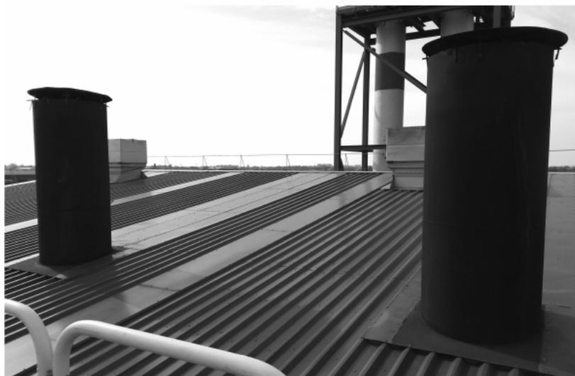
Рисунок 6 – Трубы аварийных взрывных клапанов, установленные на крыше
