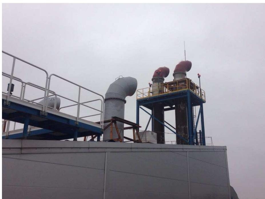
Рисунок 8 – Новый (усовершенствованный) шумоглушитель
