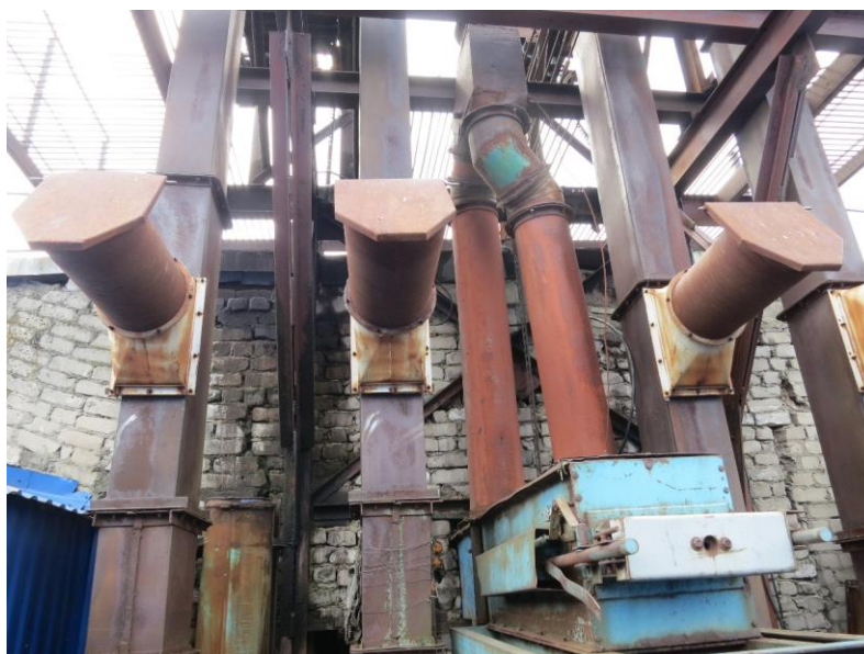
Рисунок 6 – Взрыворазрядные устройства с откидными клапанами
