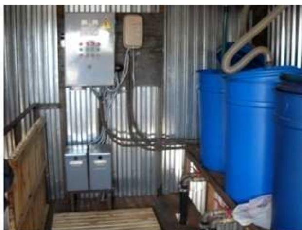
Рисунок 4. Два силовых модуля из трансформаторов и выпрямителей
