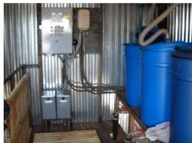
Рисунок 4. Два силовых модуля из трансформаторов и выпрямителей
