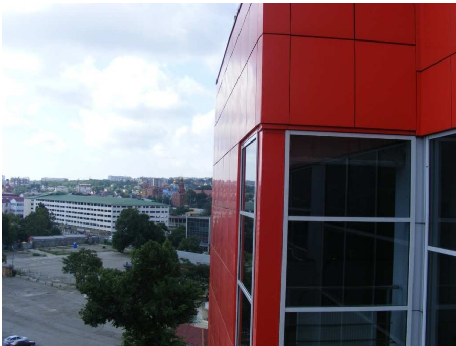
Рисунок 1–Фрагмент фасада здания
