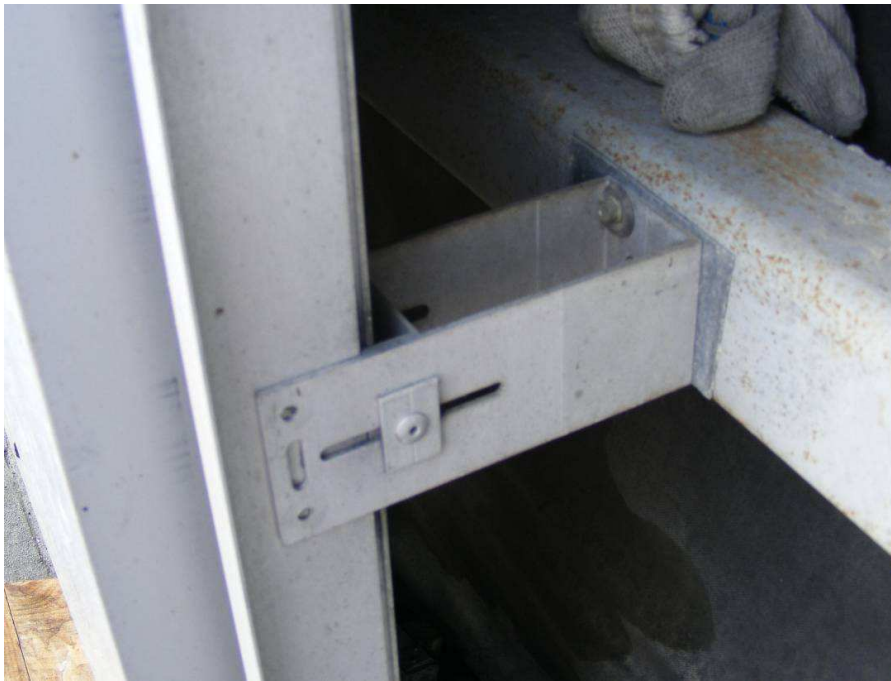
Рисунок 3 – Опорный крепежный кронштейн.
