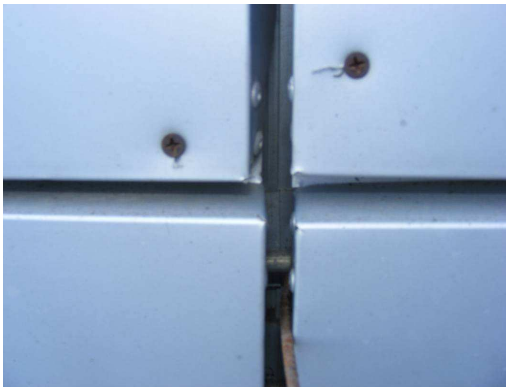
Рисунок 13– Дополнительное крепление кассет саморезами.
