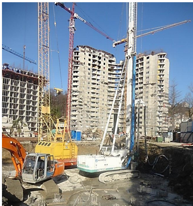
Рисунок 10– Этапы выполнения вертикального армирования основания на объекте в г. Сочи
