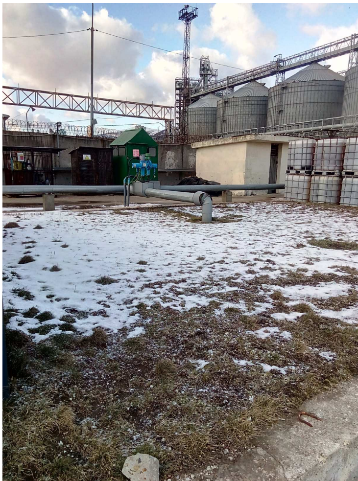
Рисунок 6 – Резервуар чистой воды (под землей)
