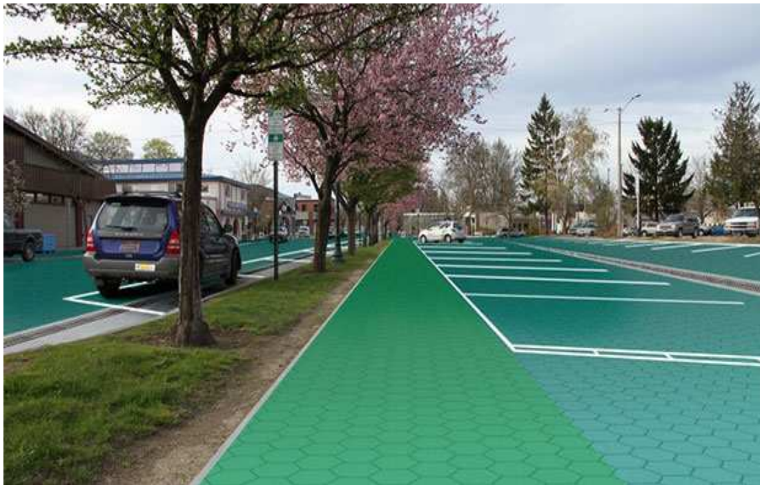
Рисунок 10 – Дорожное покрытие из солнечных панелей
