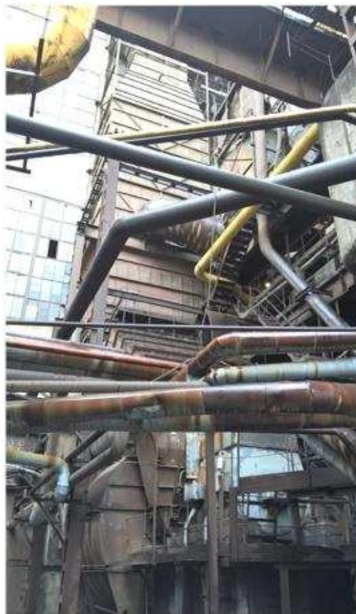
Рисунок 4 – Отвод дымовых газов, очистка на электрофильтрах
