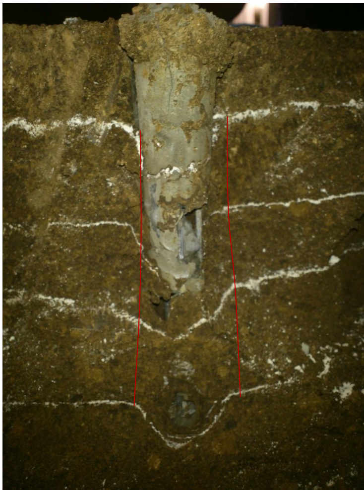
Рисунок 4 - Вертикальный срез грунта в верхней части сваи
